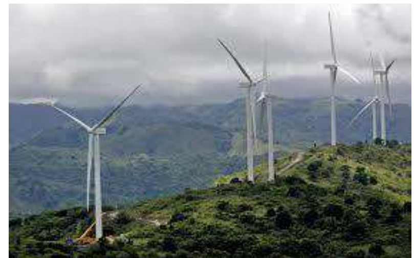
Gambar 2.14 Turbin Angin Sumbu Horizontal
