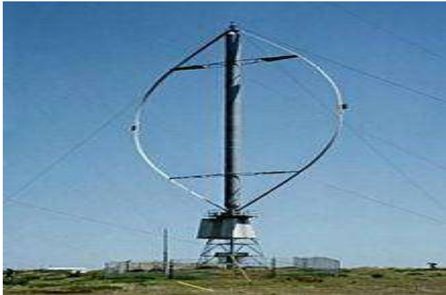
Gambar 2.15 Turbin Angin Sumbuh Vertikal
