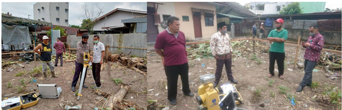
Pengukuran Kiblat Pada Pembangunan Mushalla “Taqwa Ranting Muhammadiyah Tanjung Sari Timur” Sabtu, 23 Januari 2021
