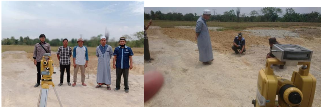
Pengukuran Arah Kiblat Pembangunan Sebuah Masjid Yayasan Siroojul Huda Daarul Uluum Di Dusun XIII- Hilir, Desa Paya Bakung Hamparan Perak, Deli Serdang Ahad 14 Maret 2021
