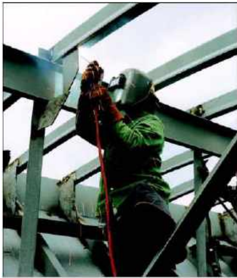
Gambar 4.9 pengelasan struktur baja dengan SMAW
